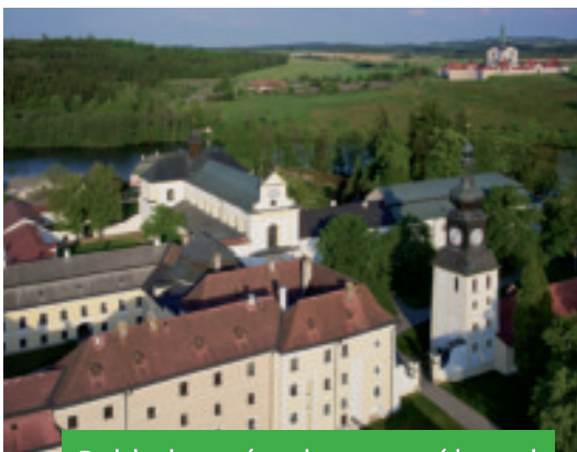
Pohled na zámek a poutní kostel
