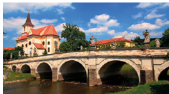
Barokní most a kostel v Náměšti
