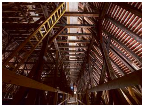
Rekonstruovaný krov střechy kostela sv. Jakuba foto Jakub Koumar
