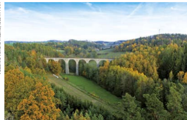
Viadukt u Velkého Meziříčí, foto: m-ARK
