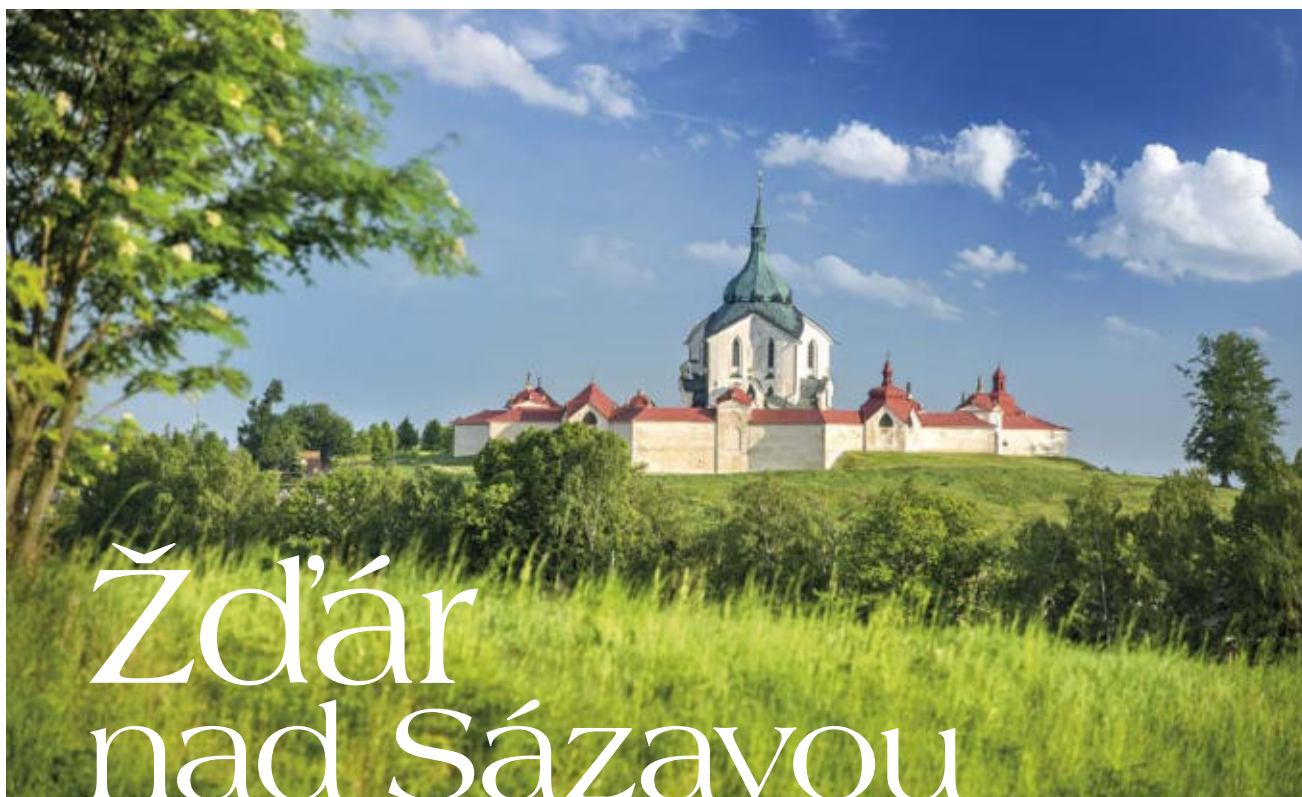
Poutní kostel sv. Jana Nepomuckého na Zelené hoře, foto: archiv města
