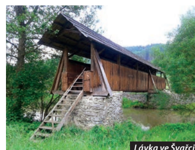
Lávka ve Švařci
